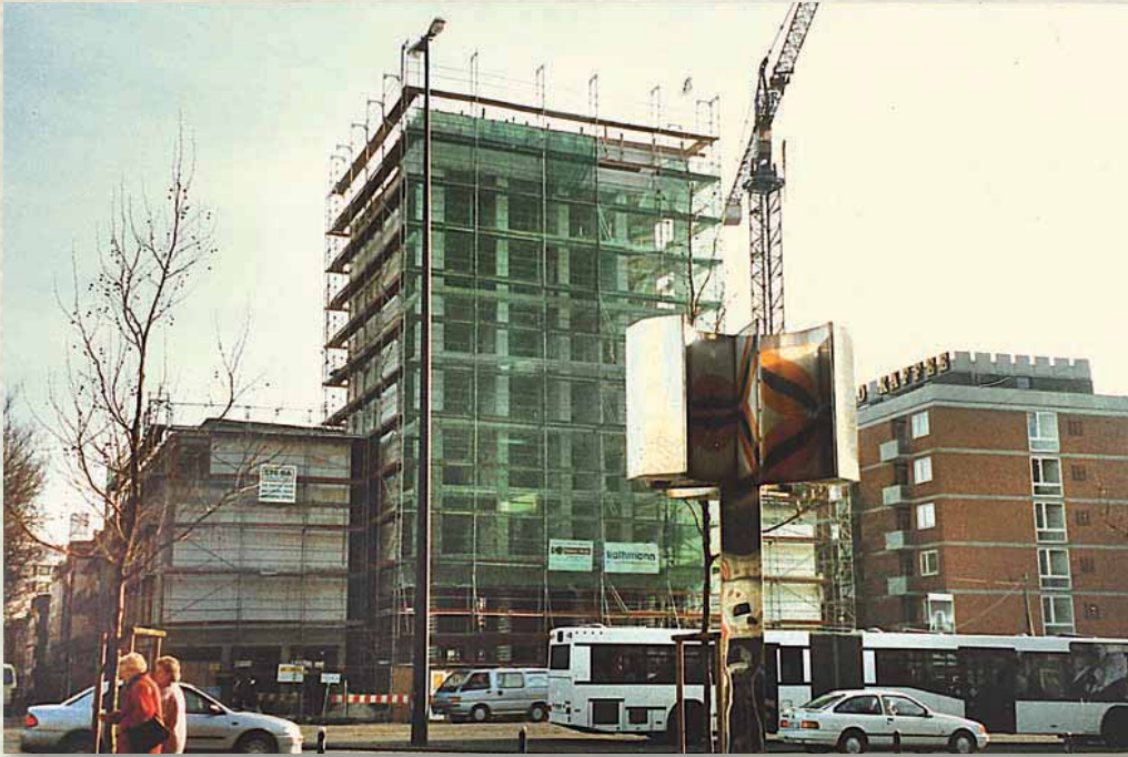
◀ Impressionen aus der Bauphase: Das Bremer Bauunternehmen Kathmann sorgte für die termingerechte Fertigstellung
